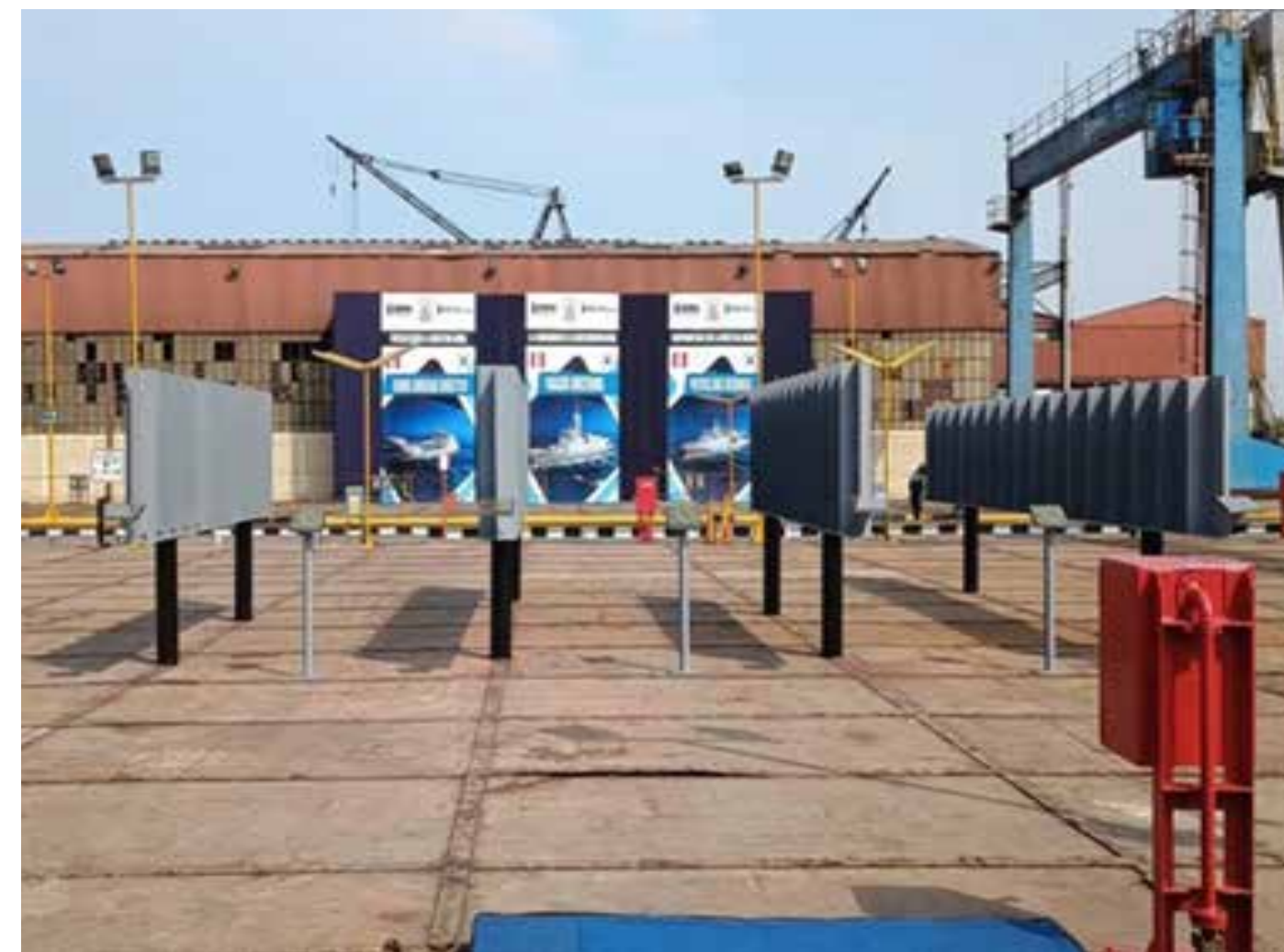
Colocación de quilla de los buque Multirrol, OPV y LCU (10 enero 2025)
